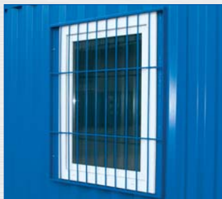
Prozor s zaštitnom rešetkom
